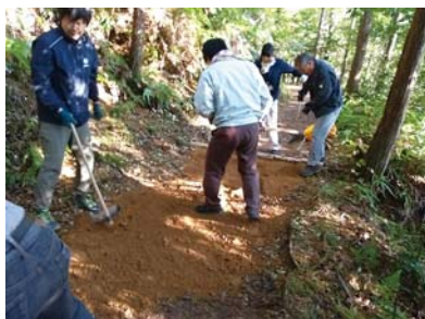
浸食によって痛んだ古道を補修
