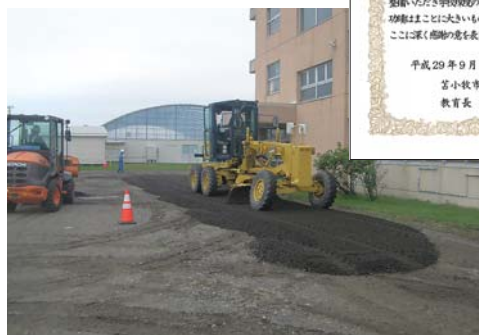
碎石を補充して整地
