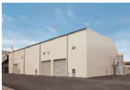
処理プラント全景
