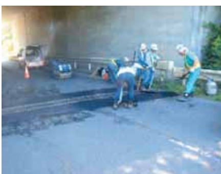
町道の路面修繕(岩手)
