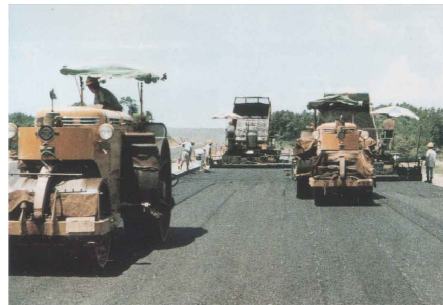
アスファルト舗装工事（昭和40年頃）
