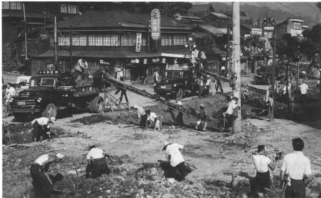
小樽市内の道路工事現場(昭和30年)
