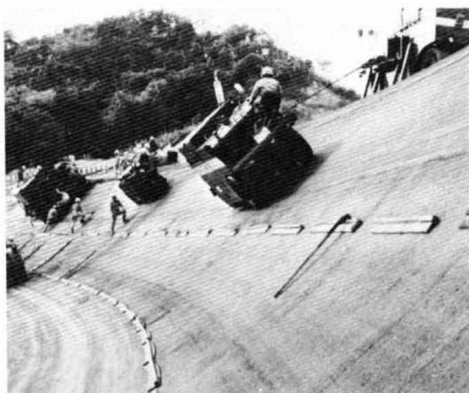
斜面舗装の試験施工（千葉）
