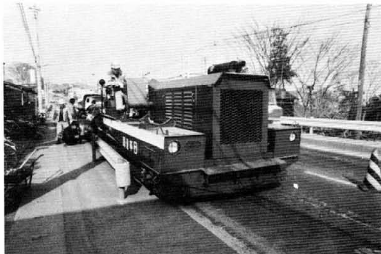
国道 246 号復旧（神奈川）
