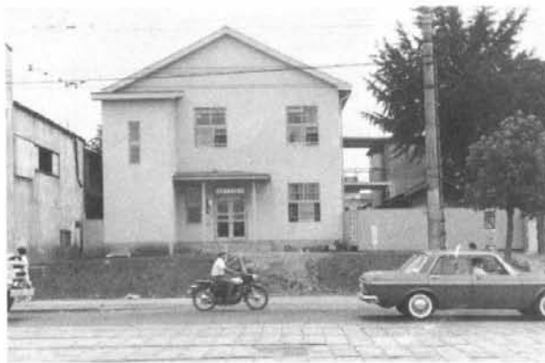
本社新築中の渋谷仮事務所
