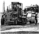
鹿児島県で施工された3D-MC
