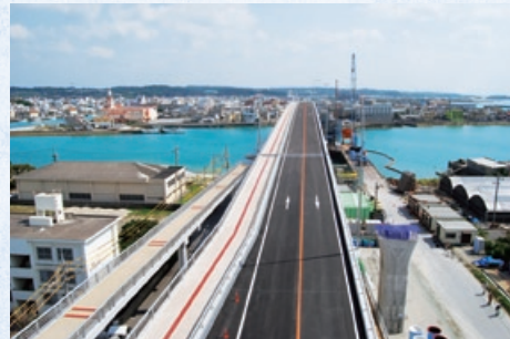
平成23年度糸満高架橋舗装（その1）工事（沖縄県）
