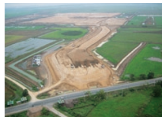
味の素アユタヤ工場-1 造成工事（タイ国）
