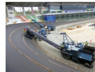
斜面舗装の施工（韓国：釜山競輪場）
