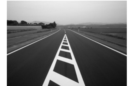
庄内空港立川線舗装整備工事（山形県）
