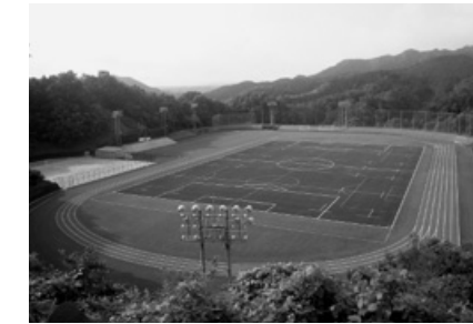
御所市総合運動公園人工芝化工事（奈良県）
