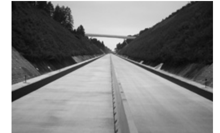
東九州道（鹿屋～曾於）後迫地区（第1工区）舗装工事（鹿児島県）
