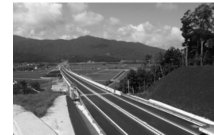
舞鶴若狭自動車道三方IC～敦賀JCT間舗装工事（福井県）
