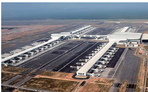
クアラルンプール国際空港第二ターミナル 舗装及びメンテ工事
