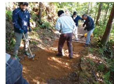
浸食によって痛んだ古道を補修
