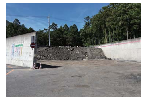
アスファルト塊の受け入れ
