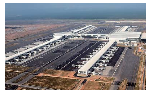
クアラルンプール国際空港第二ターミナル 舗装及びメンテ工事
