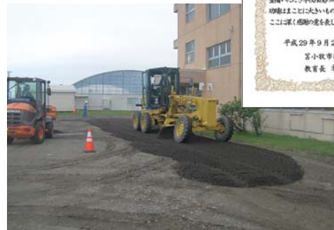
碎石を補充して整地
