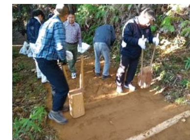
「タコ」による土の転圧
