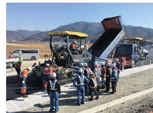
中部横断道での舗装施工現場の見学
