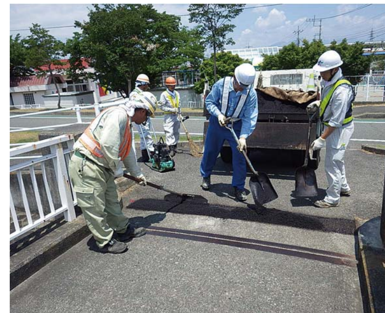
段差のすりつけ作業
