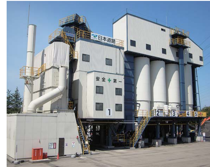
埼玉合材センター全景
