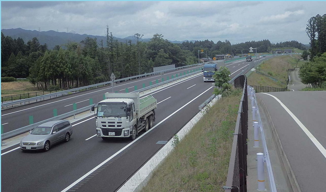
全線開通した常磐自動車道／南相馬市・浪江町境付近
