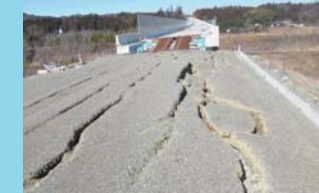
本線盛土部では亀裂が随所に発生
