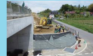
橋梁・BOX廻りは補強土壁から復旧
