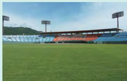
県営あづま球場除染作業完了
