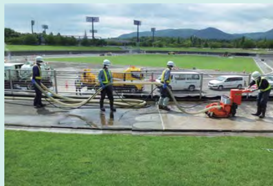
陸上競技場 高圧洗浄除染作業状況
