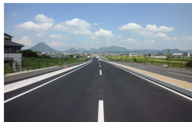
室塚舗装工事(香川県)
