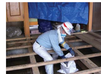
床下のヘド口撤去
