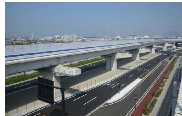
広島南道路宇品舗装工事(広島県)
