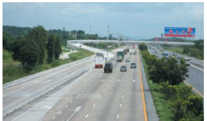
サラブリバイパス東側第二工区(タイ国)
