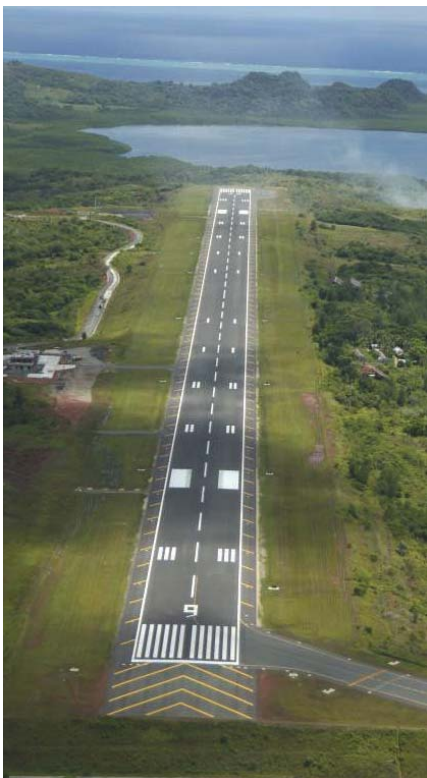
パラオ国際空港滑走路改修工事(パラオ共和国)
