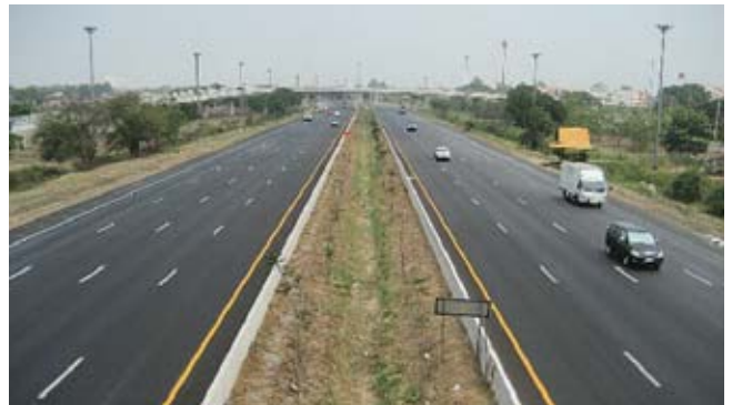
国道32号線バンパハン地区改良工事(タイ国)
