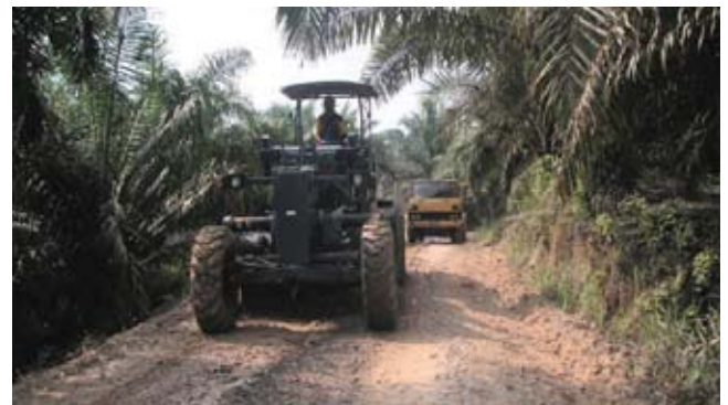
プランテーション道路改修工事(マレーシア国ボルネオ島)
