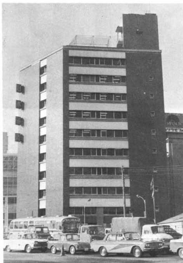
新築落成した本本社屋（昭和40年）
