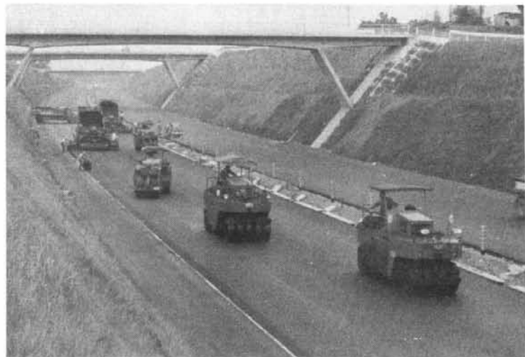
東名高速道路浜松～袋井間舗装工事（昭和42年）
