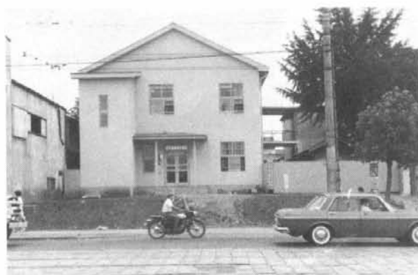
本社新築中の渋谷仮事務所
