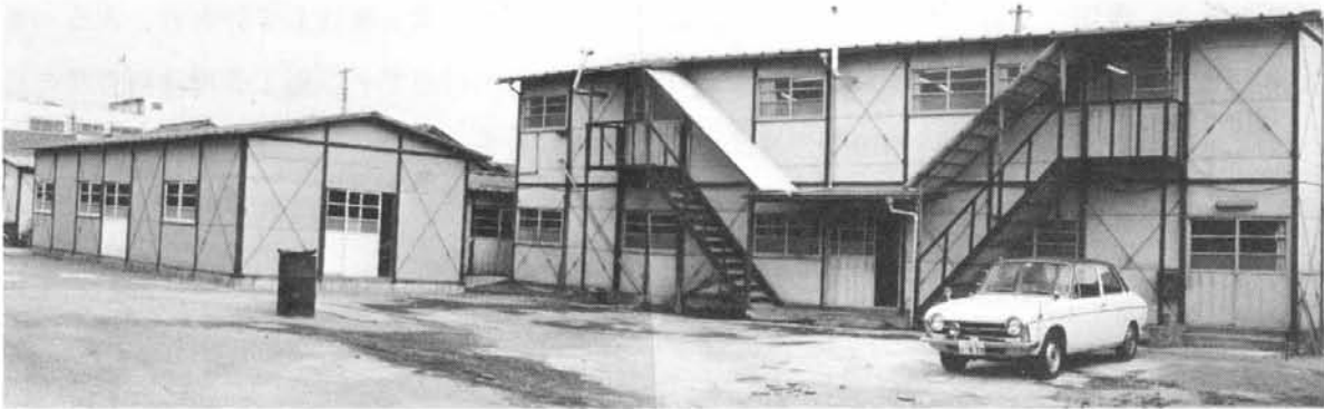
旧技術研究所の建物全景（昭和45年頃）
