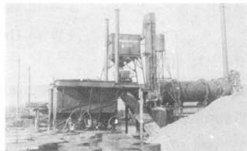
当社の800ヤードプラントの第1号機 ケトルの鉄輪付が時代を物語っている
