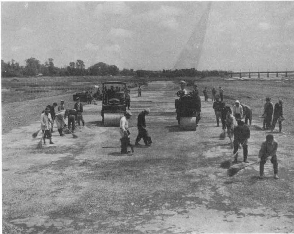
読売飛行場舗装工事（昭和26年）
