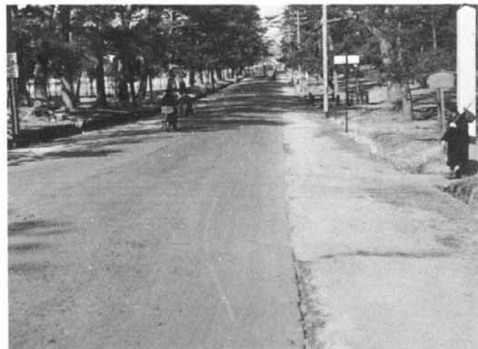
奈良—国道15号線舗装工事 (昭和26年)
