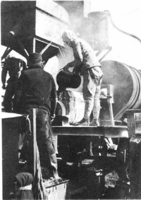
当時のアスファルトプラント（昭和28年） 400ヤード、アスファルト投入はバケツ使用
