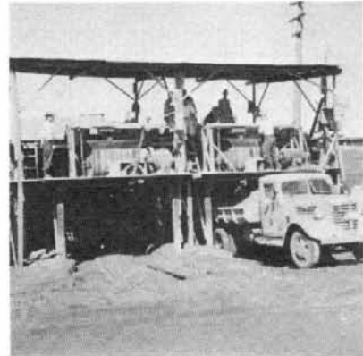
所沢行政協定工事（昭和28年） スランプゼロのコンクリートを 混合するバグミルプラント
