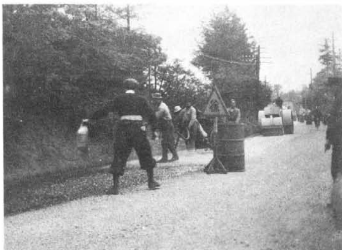
杉並区荻窪～高井戸間路面補修工事 （昭和24年）（米軍から払下げられた MC-3による舗装工事）
