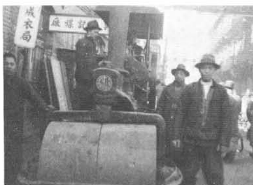
北京市内舗装工事現場
