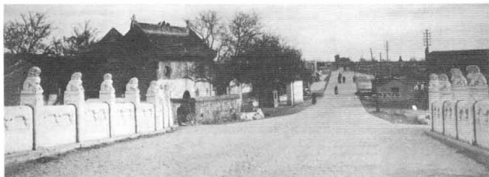
北京市蘆溝橋舗装 工事(昭和14年)
