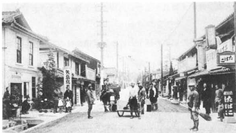
松本市内舗装工事（昭和8年）
