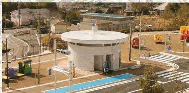
● トイレ ユニークな形のトイレ。
